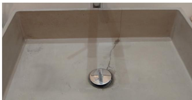
**Les bondes sont équipées de 2 joints haut et bas**, qui assurent l'étanchéité, mais aussi la fonction de dilatation du produit; **si le serrage est trop important, celui-ci ne joue plus son rôle.**
