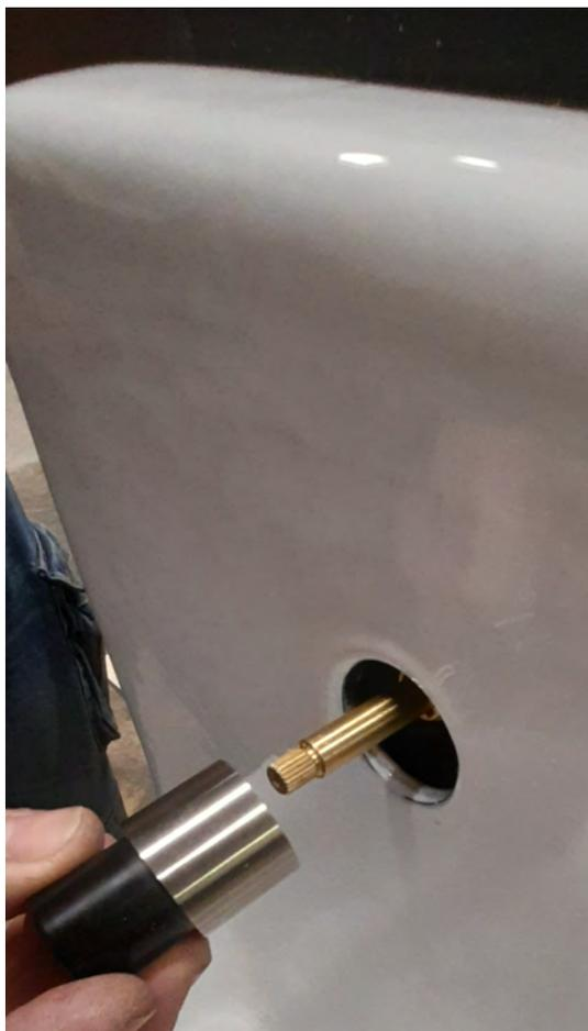
Le bec n'oubliez pas d'installer du téflon ou autre matériel d'étanchéité sur le pas de vis :
